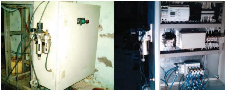
**Figura 10. Instalación de gabinete de control con sus accesorios.**
